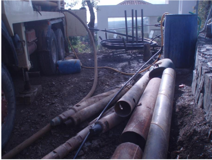
Figura N° 8 Introducción de colectores, Benahavis
