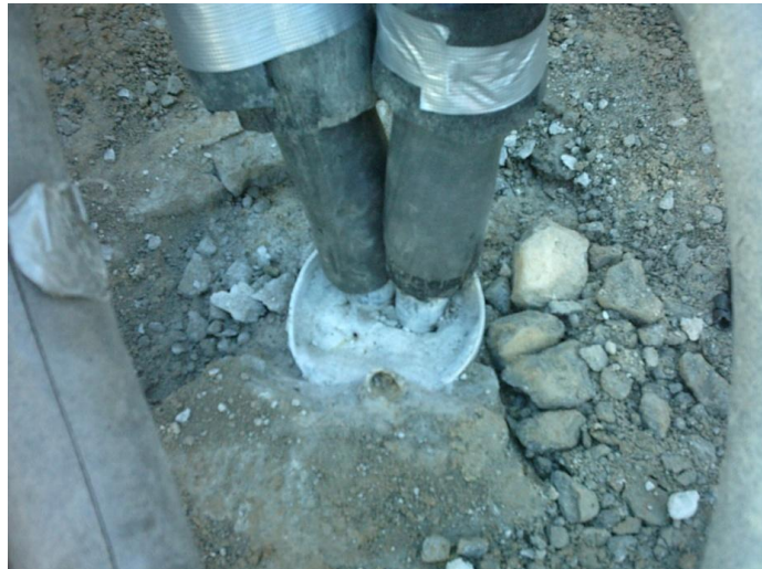
Figura N° 9 Sondeo acabado con cemento
