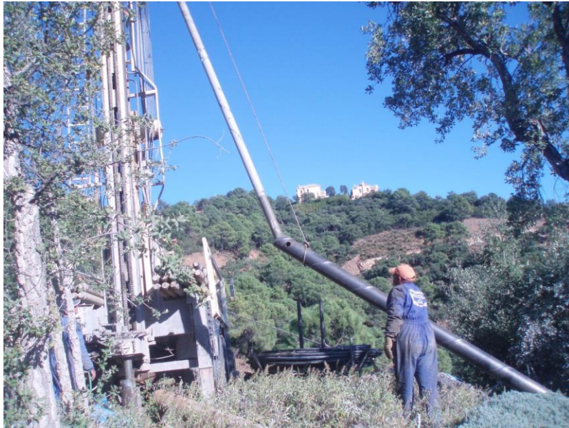
Figura N° 4 Sondeo para geotermia, Marbella, Málaga
