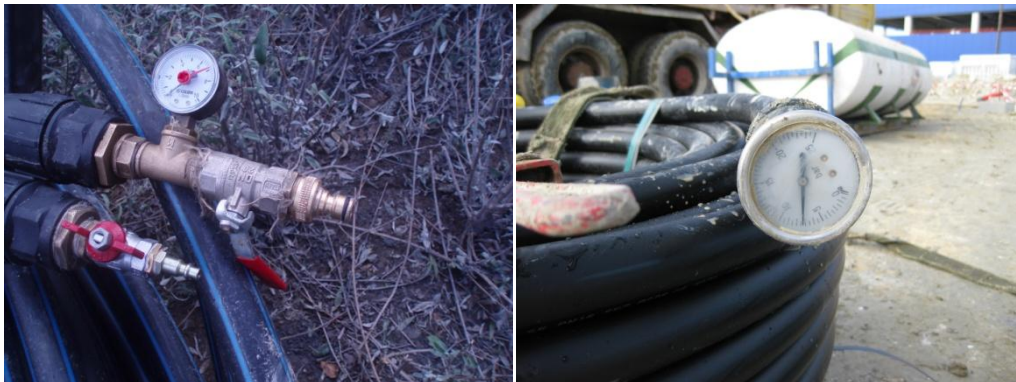
Figura N° 7 Prueba de presión antes de introducir el colector
